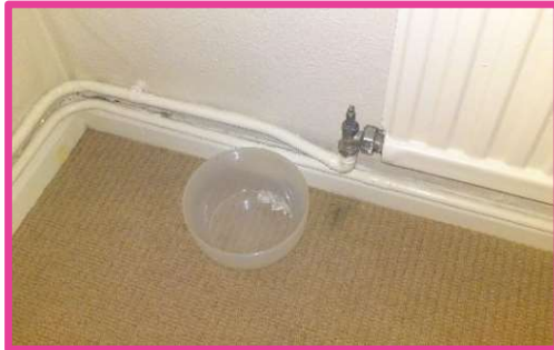
Radiátor tömítése
