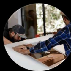
Konyhai beépítések, szerelések
